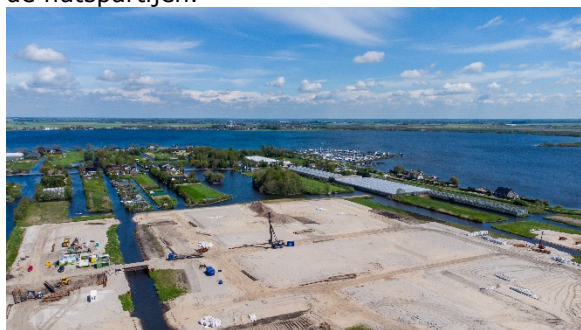
Foto: Bouwrijpwerkzaamheden De Poelen fase 1
