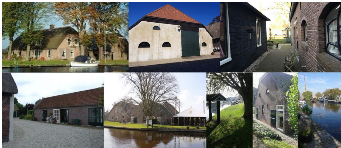
Bestaande situatie (bron: VPR Consultants, d.d. 23 februari 2023)
